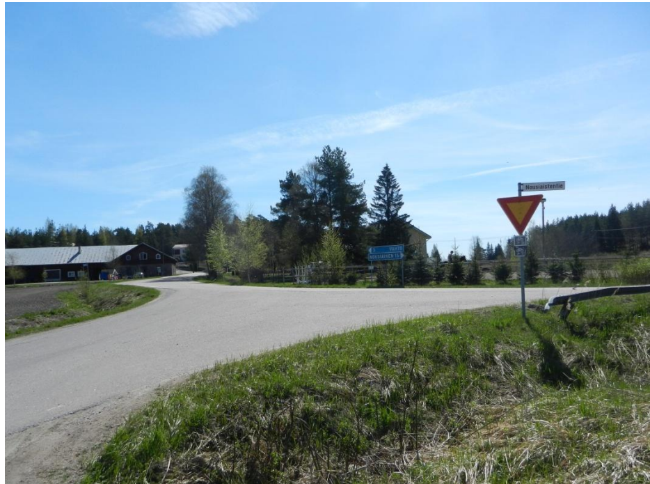
Kuva 2. Torikkalantien liittymä maantielle 2010.
