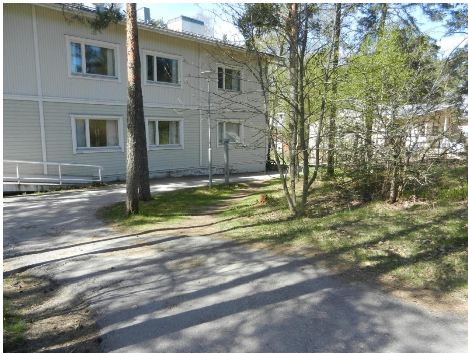
Kuva 16. Suojatie johtaa ja ohjaa kevyen liikenteen kiinteistön pihaan.
