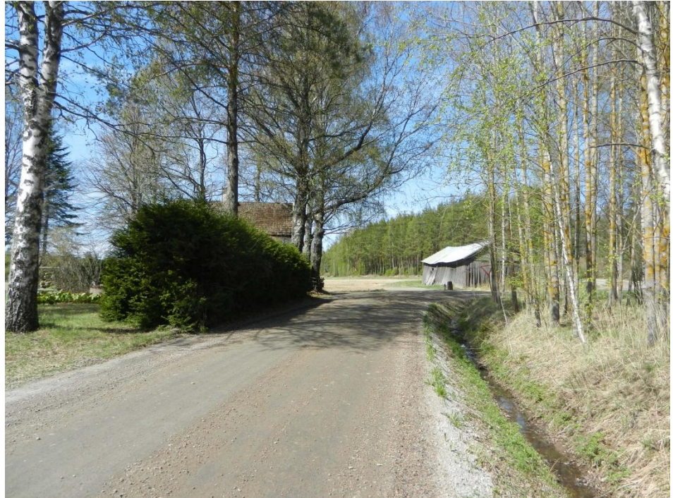
Kuva 7. Näkemät Airikkalantieltä Lavamäentielle ovat huonot.
